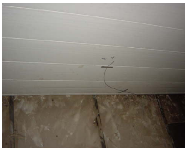
Forro de PVC montado na sala de ensaio conforme NBR14371
