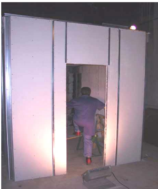
Sala onde o forro de PVC foi montado
