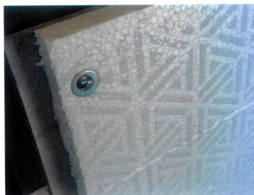
Figura 3: Detalhes da fixação das placas de poliestireno.
