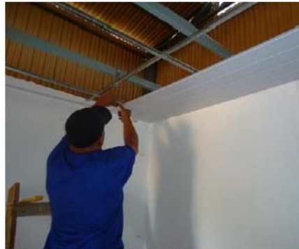
Colocação dos perfis de PVC para forro
